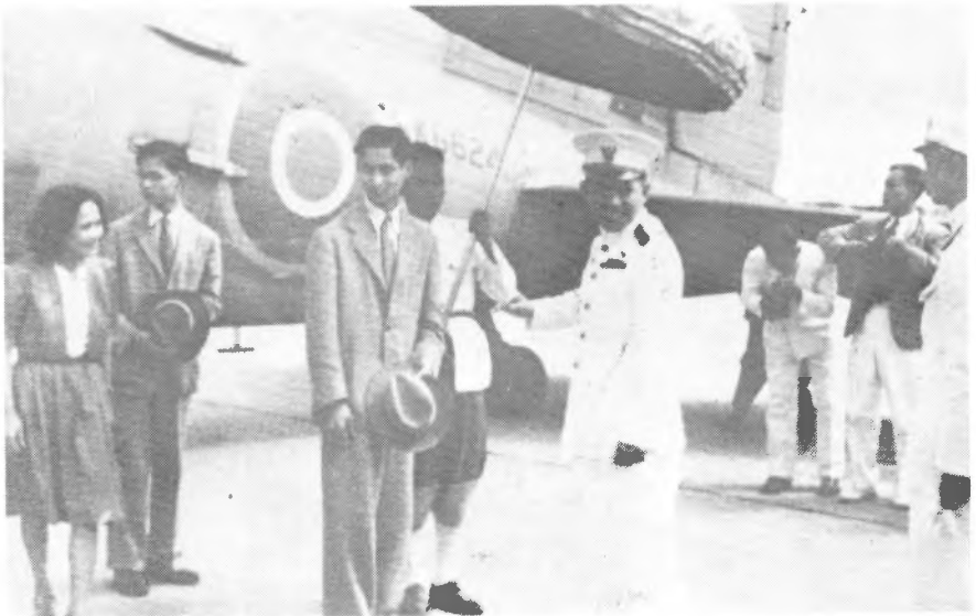
ถวายการต้อนรับ พระบาทสมเด็จพระเจ้าอยู่หัวอานันทมหิดล สมเด็จพระอนุชา และสมเด็จพระราชชนนีเสด็จนิวัติ จากสวิตเซอร์แลนด์สู่กรุงเทพมหานคร
