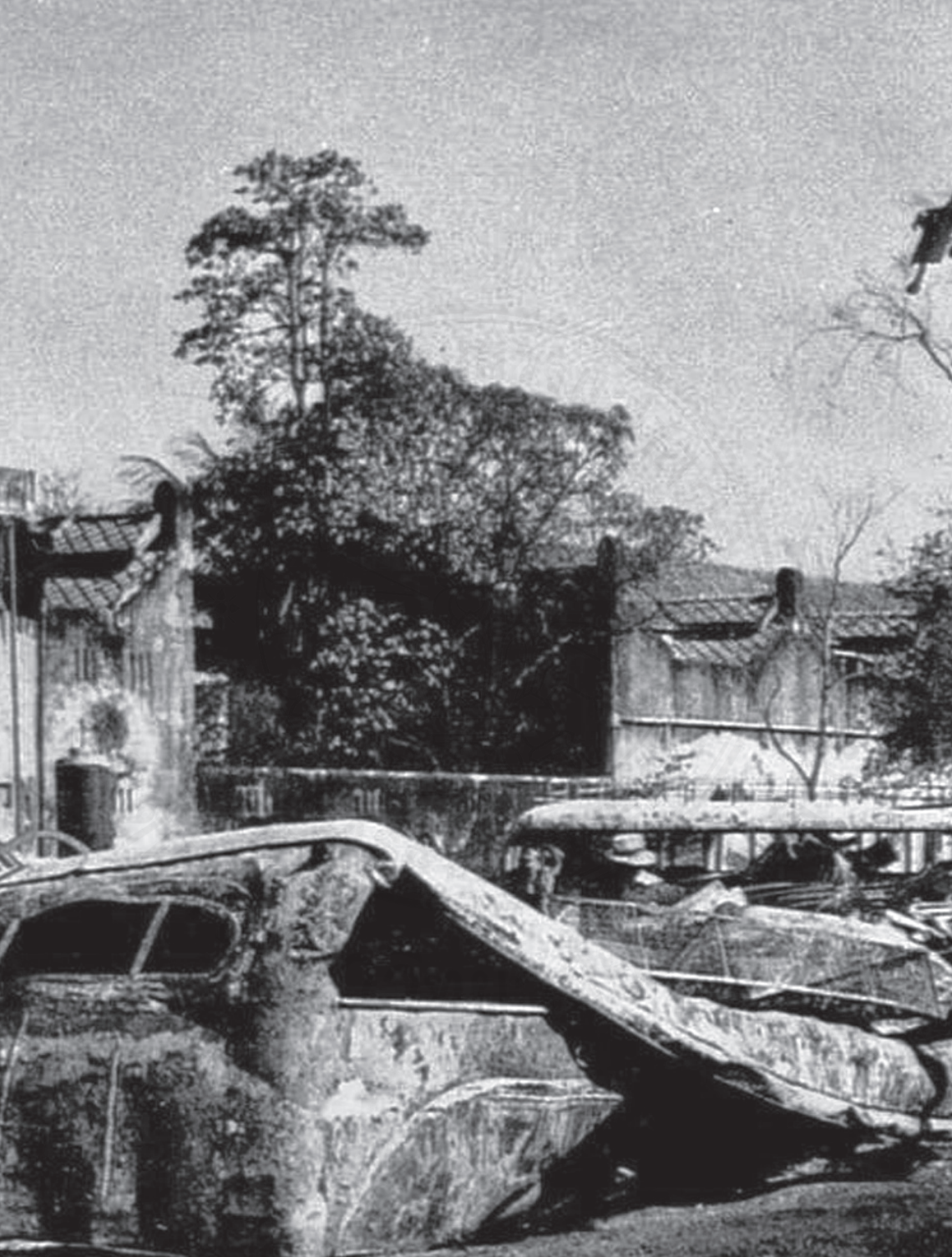
ไฟไหม้พันธมิตรทิ้งระเบิดบริเวณสถานีรถไฟกรุงเทพช่วงกลางเดือนมกราคม พ.ศ. 2487
