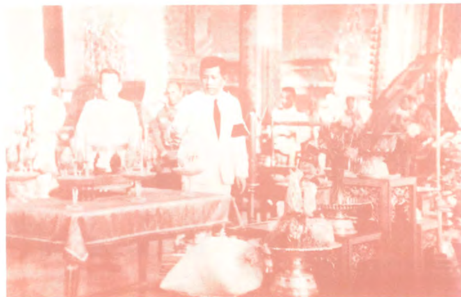
ทำหน้าที่แทนพระองค์ในงานพระราชพิธีงานหนึ่ง
